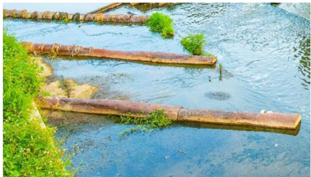
二期工程將參考大窠坑溪一期營造工法，於河道內設置原木丁壩及擾流工構造，營造適合生物棲息之近自然河川環境。
