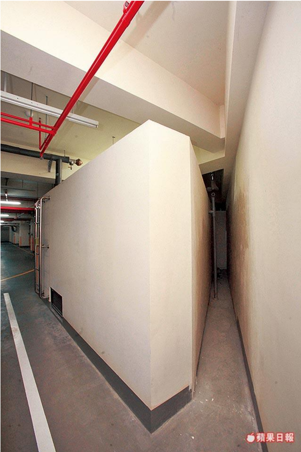
區地下室停車場複壁與連續壁間沒有排水導溝，造成漏水現象發生。
