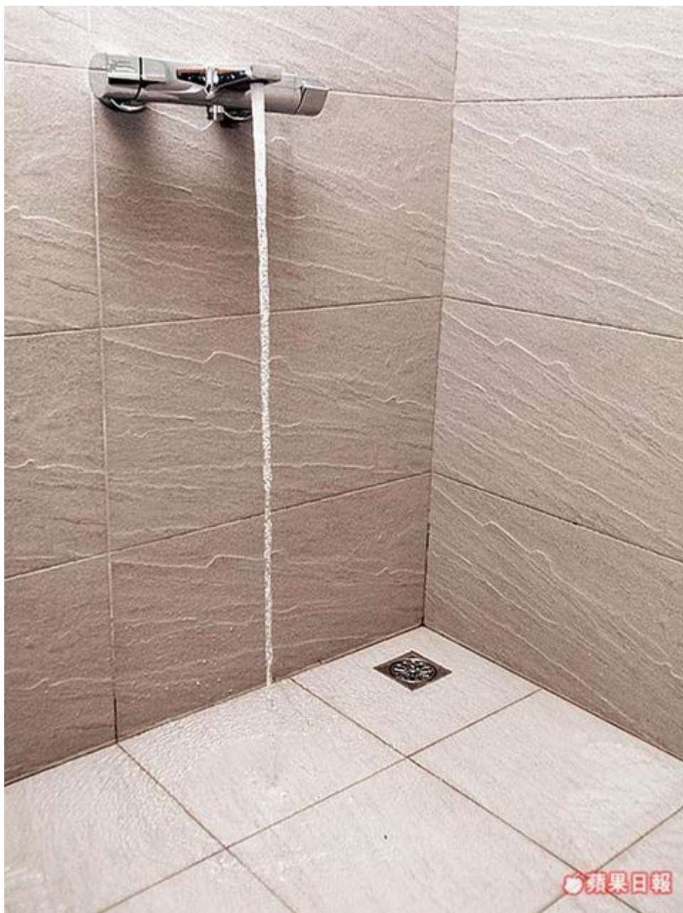
衛浴空間的地板有洩水坡度，放水測試排水是否順暢。
