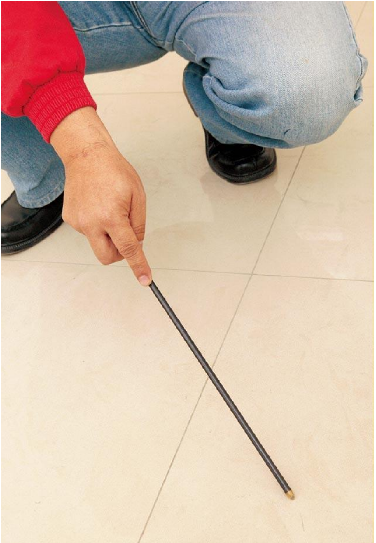
查驗地板是否「澎共」(台語)是大工程，建議可拿有塑膠頭的工具輕敲，聽其回饋聲響。
